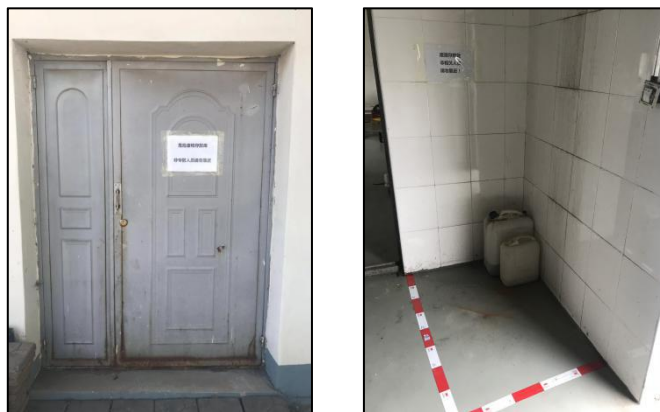
照片 4-4 危废暂存处
